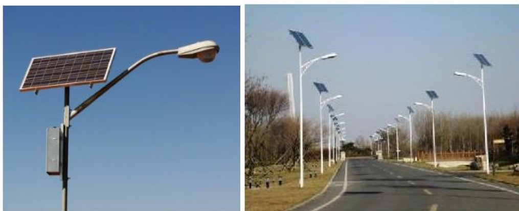
Figura 8.13 – Iluminação pública através de painéis solares
