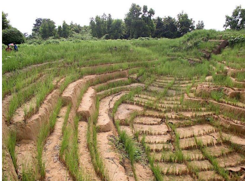
Figura 8.7 – Recuperação de ravinamento com capim vetiver no Congo. (Fonte: Elder Madrugá).
