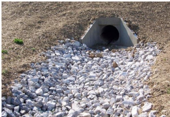
Figura 8.8 – Exemplo de bacia de dissipação em enrocamento.
