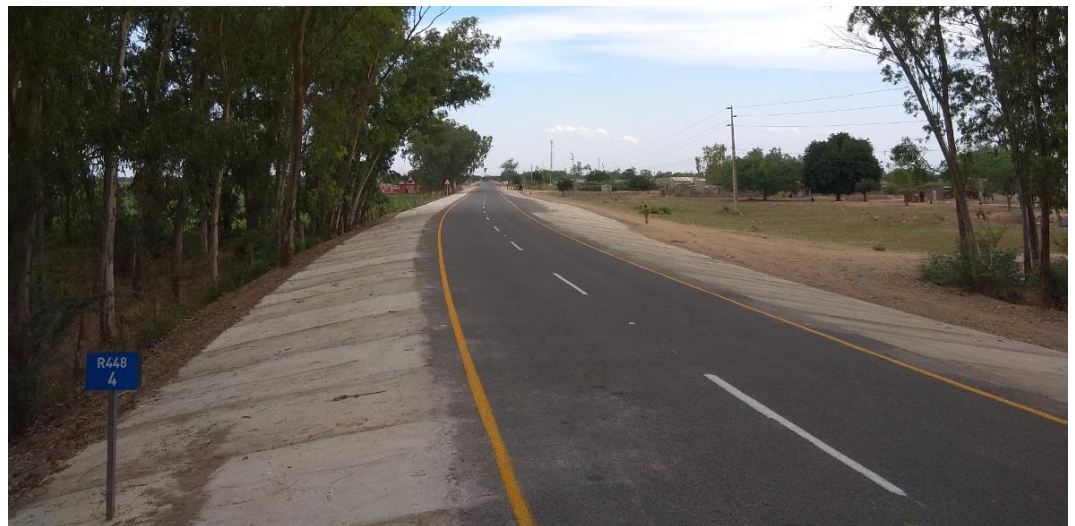
Figura 6.16 – Aspeto da R448 após reabilitação, com sistema de protecção de taludes
